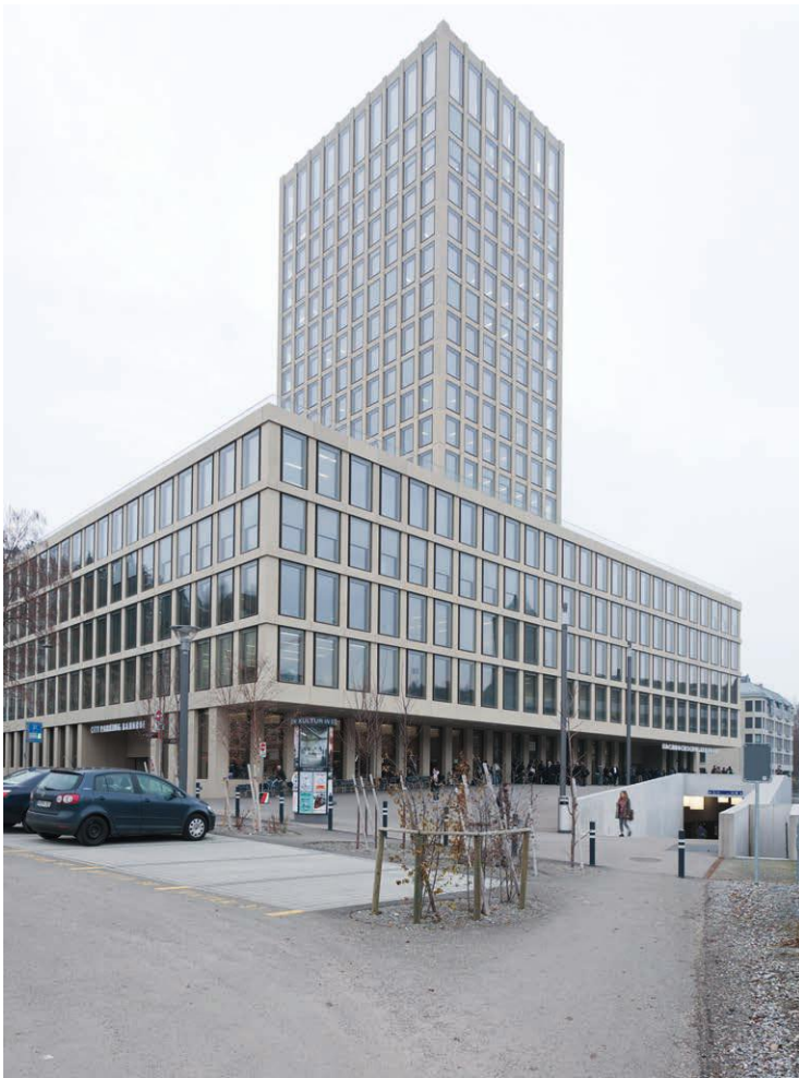
FHS St.Gallen: Sockelbau und Turm.
